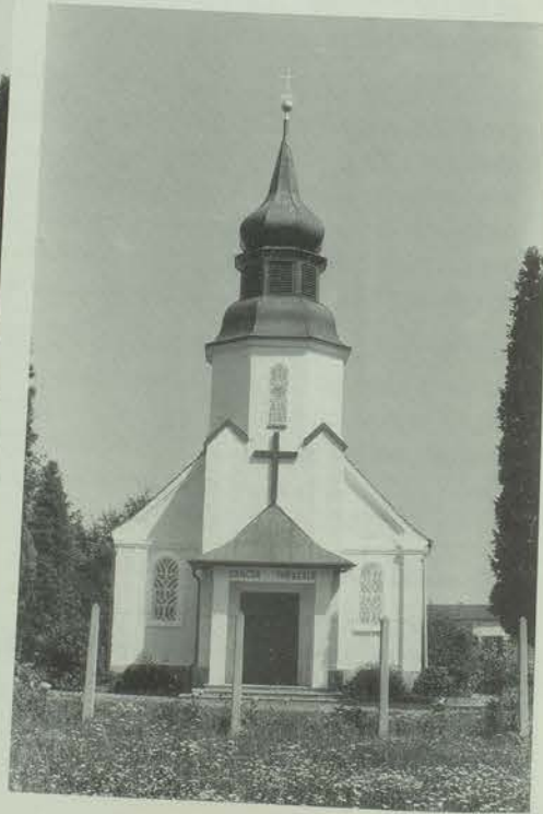
Sommer '87 nach der Renovierung
