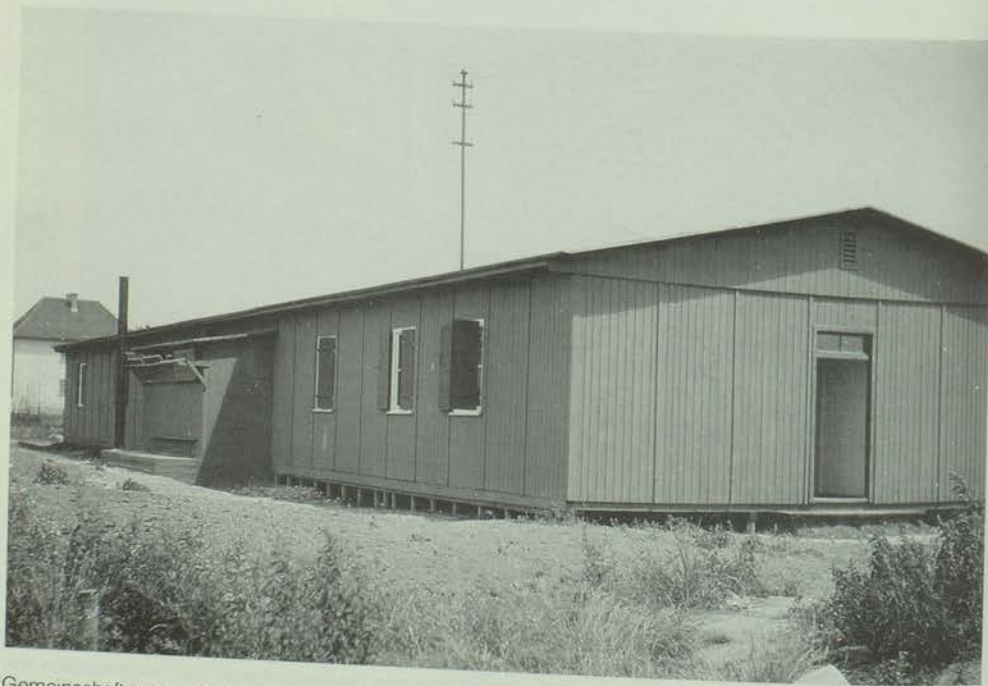
Gemeinschaftsraum, Werkstätte u. Schneiderei
