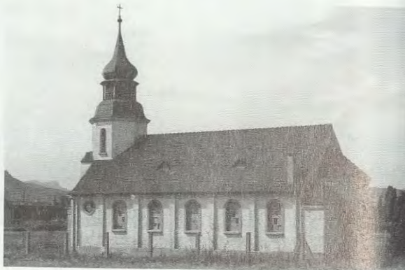
Die Fenster der Kapelle St. Theresia zeigen erste Zerstörungen: Die Südseite in den 1950er Jahren
