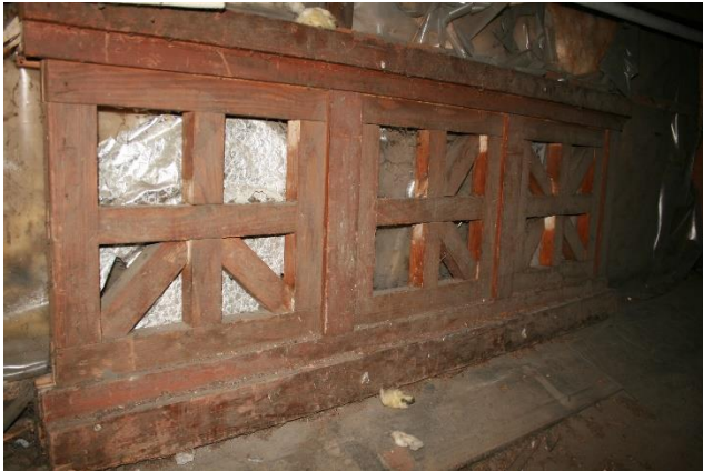
Abb. 59: Kommunionbank auf dem Dachboden der Kapelle.
